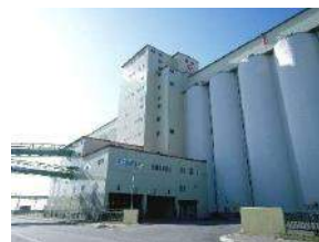
穀物サイロ施設
