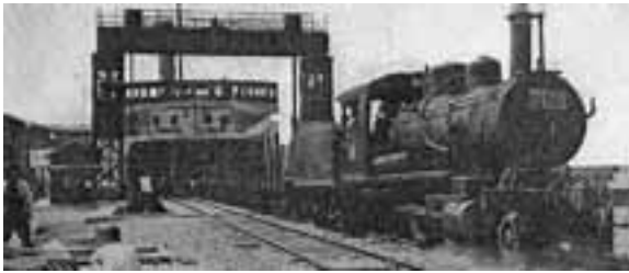
写真1(本文中 写真1-10) 連絡船貨車積卸作業 『北海道の港湾』より転載
