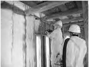
図6. 内断熱工事
