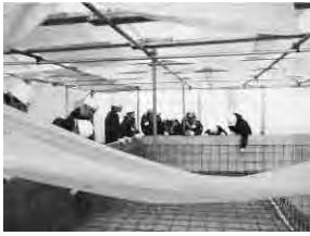
図2. 基礎工事風景
