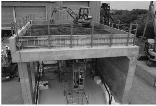
写真3 敷砂締固め状況
