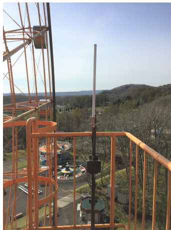
図3 中心拠点におけるアンテナの設置状況
